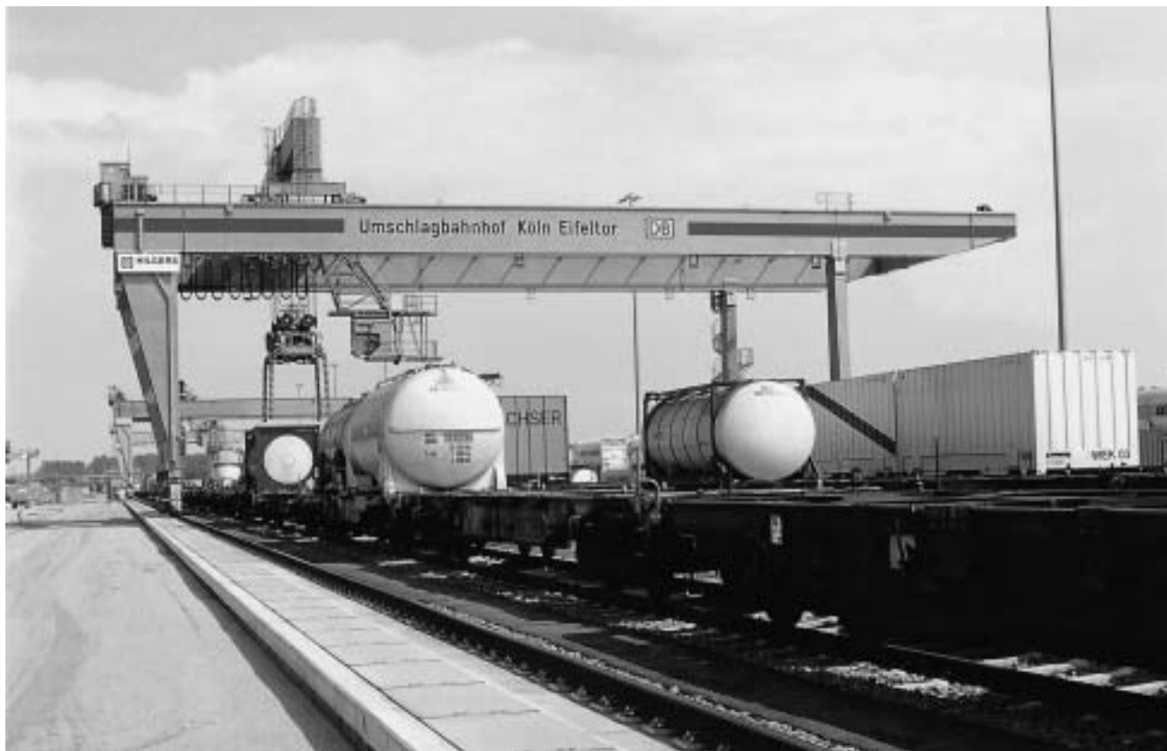
Canal subterráneo-EID en una Terminal de contenedores.
