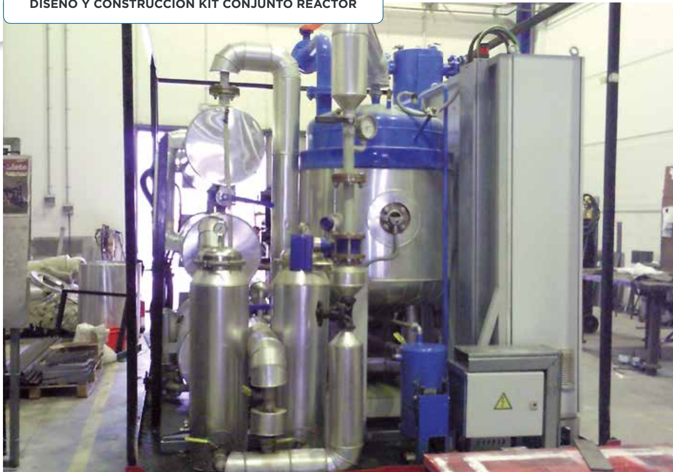
DISEÑO Y CONSTRUCCIÓN KIT CONJUNTO REACTOR
