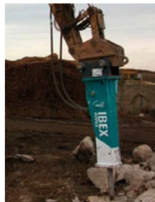
DEMOLICIÓN DE EDIFICIOS
