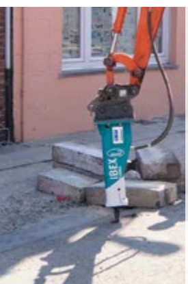
ASFALTO Y PAVIMENTACIÓN
