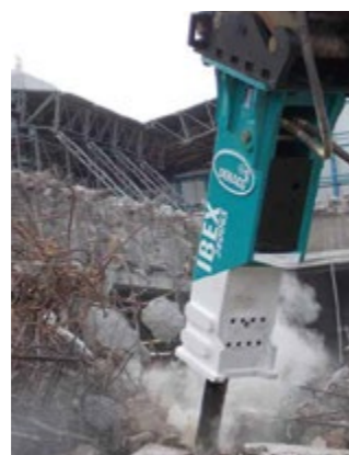
CONSTRUCCIONES DE HORMIGÓN
