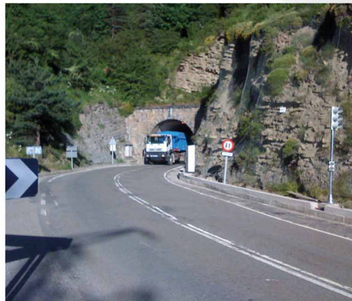
TUNEL DE COTEFABLO EN LA N240 (PIRINEO DE HUESCA): SISTEMA DE CLASIFICACIÓN POR TAMAÑO MEDIANTE PIEZOELECTRICOS PARA REGULACIÓN SEMAFÓRICA.
