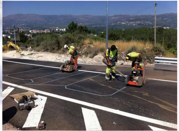
DOS EQUIPOS DE INSTALACIÓN DE AFOROS TRABAJANDO JUNTOS EN PORTUGAL. INSTALACIÓN DE ESPIRAS Y PIEZOS.
