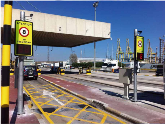
PUERTO DE VALENCIA: PANELES INDICADORES DE VELOCIDAD. REPORTAN DATOS EN TIEMPO REAL AL SCADA CORPORATIVO
