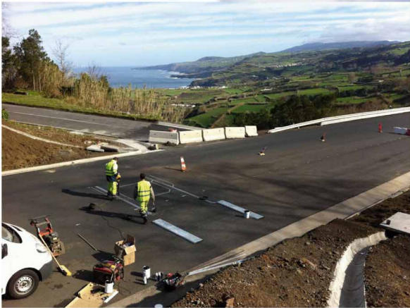
EUROSCUT AZORES: 20 ETDS (64 CARRILES) DE AFORO Y CLASIFICACIÓN CON PIEZO-LAZO-PIEZO PARA INDRA.
