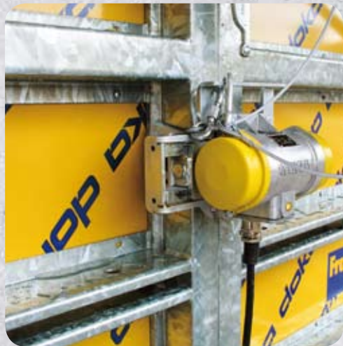
Dispositivo de sujeción SV 5 aplicada
