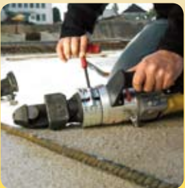
5 Fijar la abrazadera de fijación.
