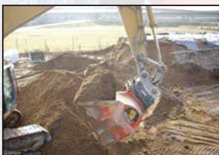
Estabilización de tierra contaminada
