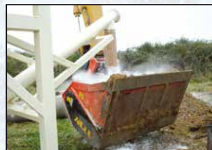
Estabilización con cal
