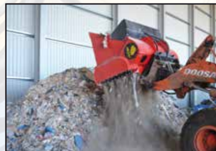
Trituración de desechos de demoliciones
