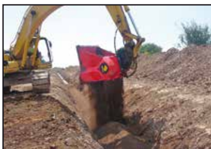
Relleno de zanjas para tuberías
