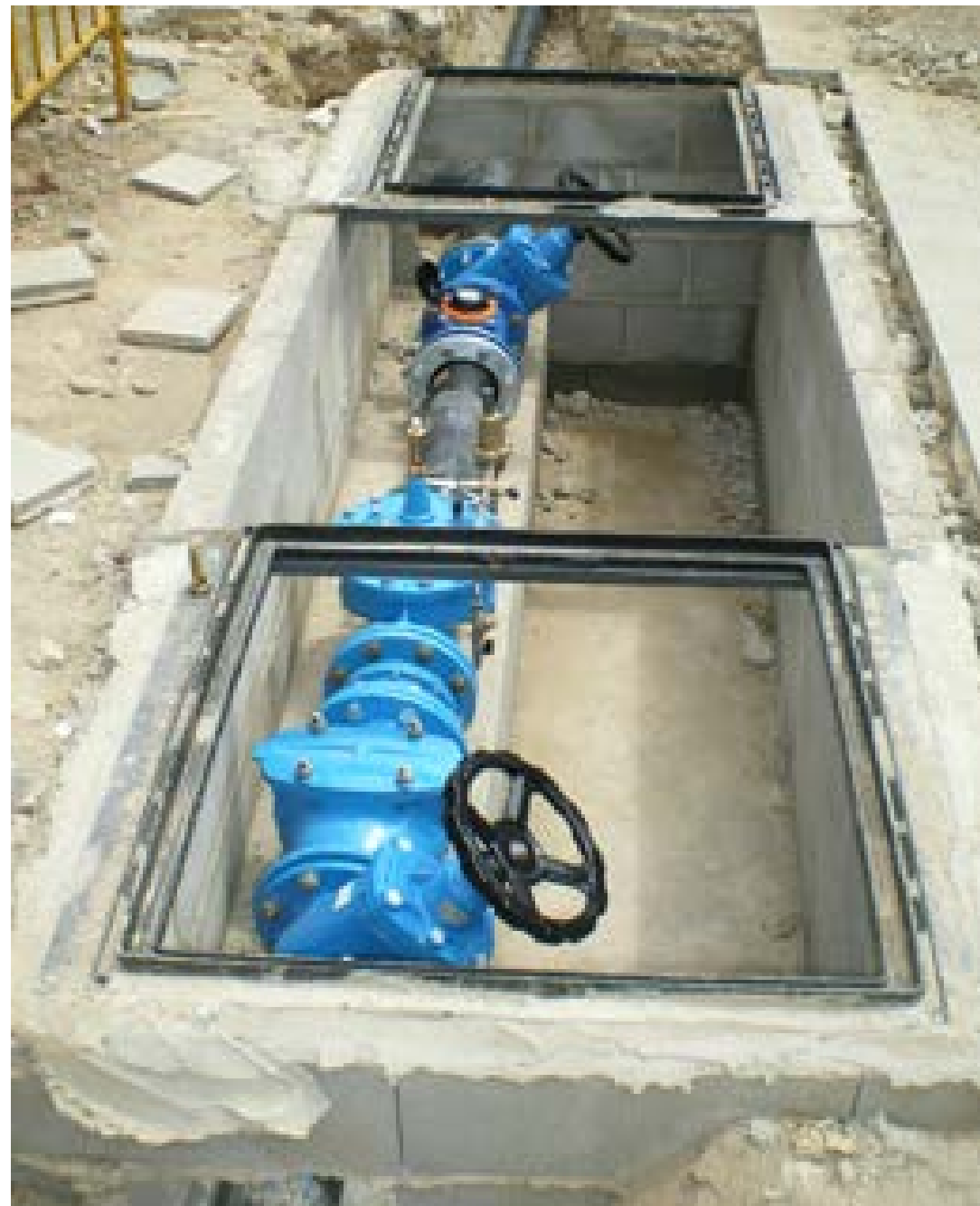
Montaje de válvula reguladora de presión en arqueta
