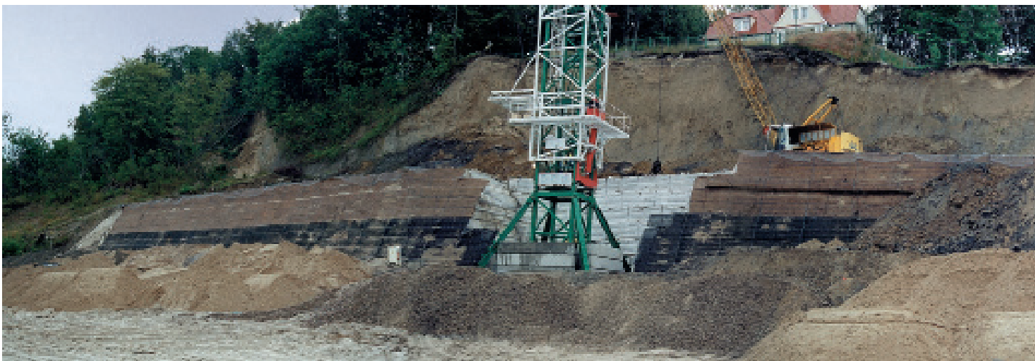
54. Slope stabilization, Jastrzebiej Gorze-Poland.
