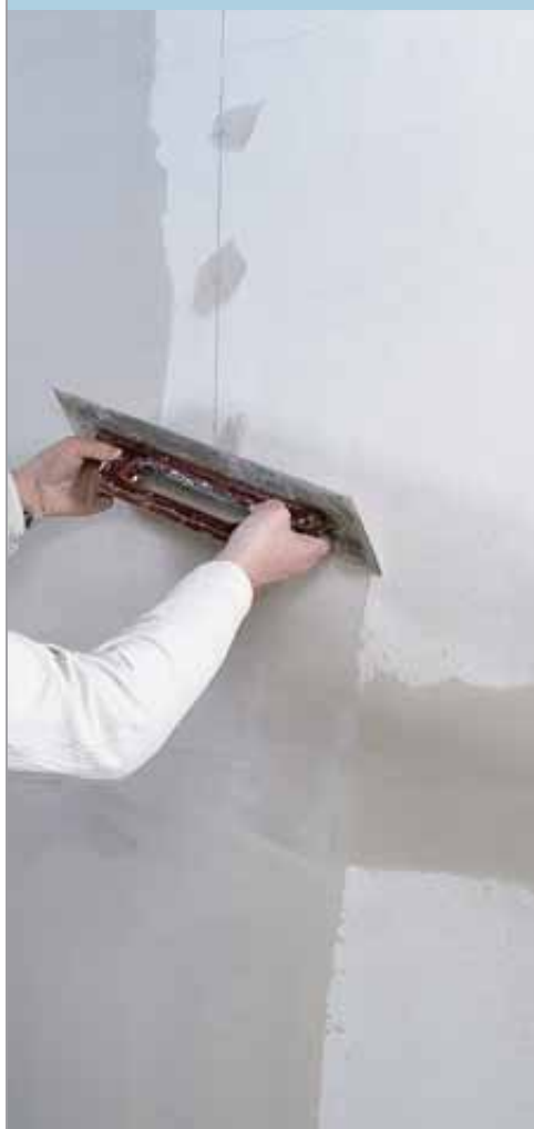
Colocación del impermeabilizante superficial Knauf sobre la placa instalada
