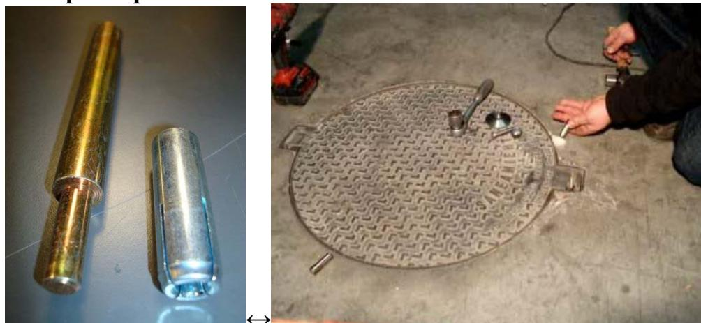
**A continuación se mete el accesorio expansionador y con un martillo se golpea hasta que haga tope y este el taco expandido, se quita el expansionador y se introduce el tornillo antirrobo con la arandela y con un poco de grasa en la punta del tornillo se aprieta con la llave antirrobo esta llave esta fabricada para que se pueda apretar con cualquier cerracla, llave fija o inglesa, o dinamométrica el par de apriete recomendable es de 4Nm.**
